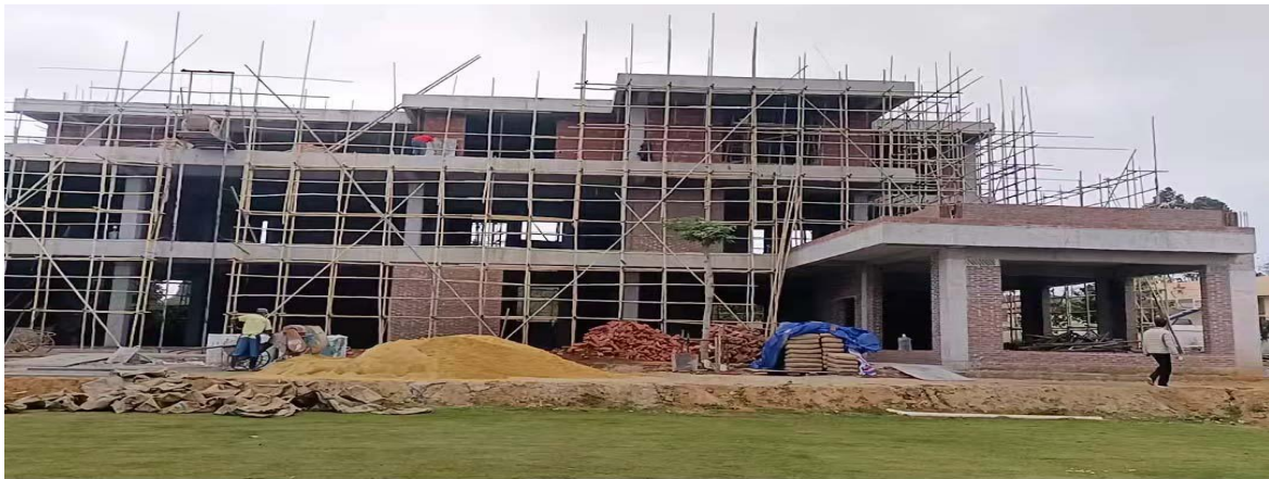
项目施工现场
